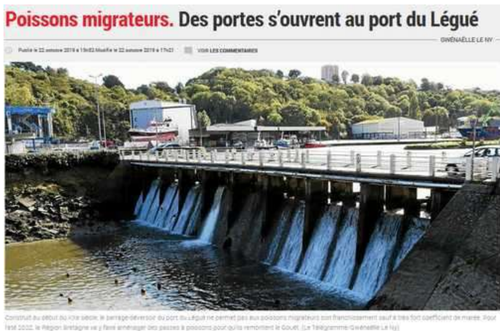
Figure 8 : l'écluse du port du Légué
