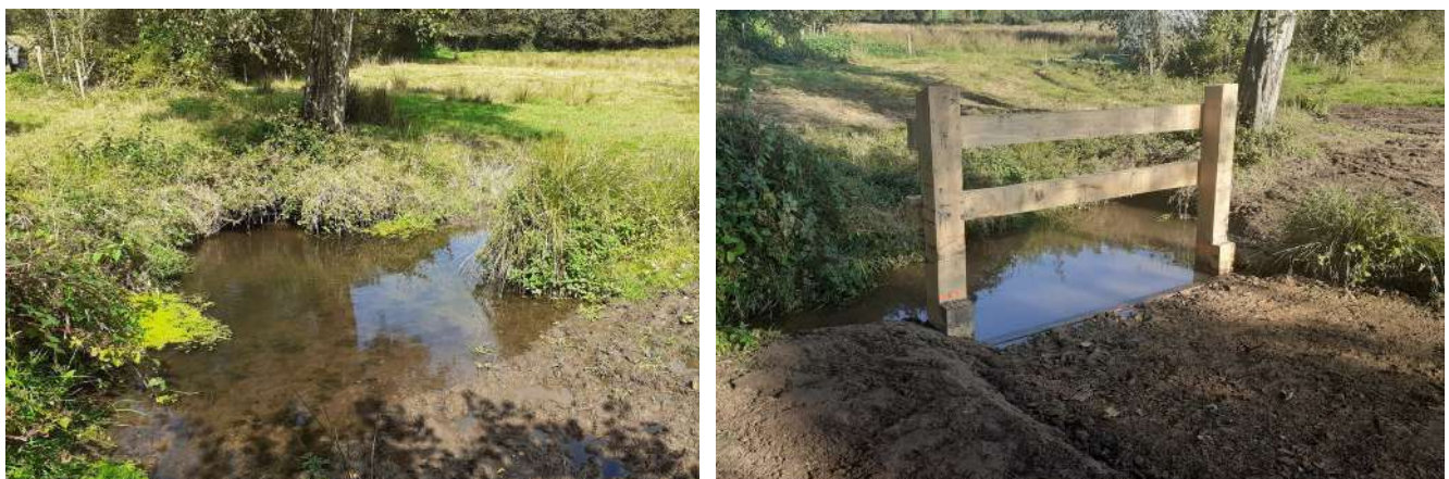
Figure 18 : Une des descente aménagée en 2020 (LM1-4) : avant (à gauche) & après (à droite)
