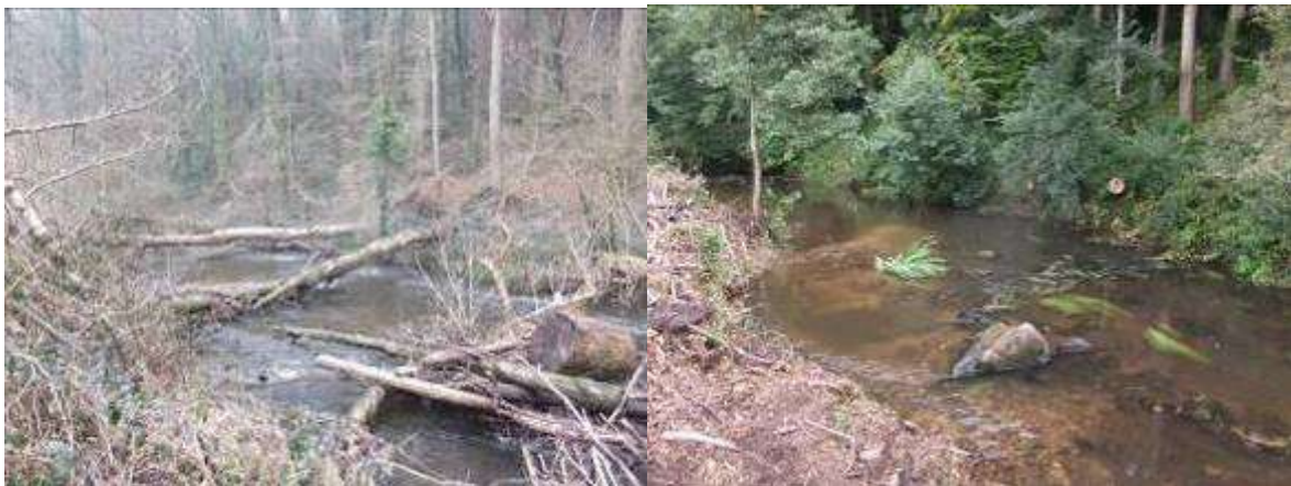
Figure 43 : Exemple d'embâcles avant et après travaux réalisés en septembre 2015
