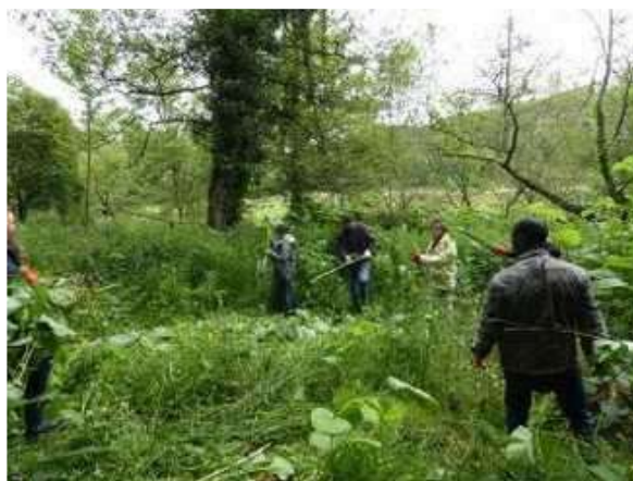
Figure 14 : chantier en cours
