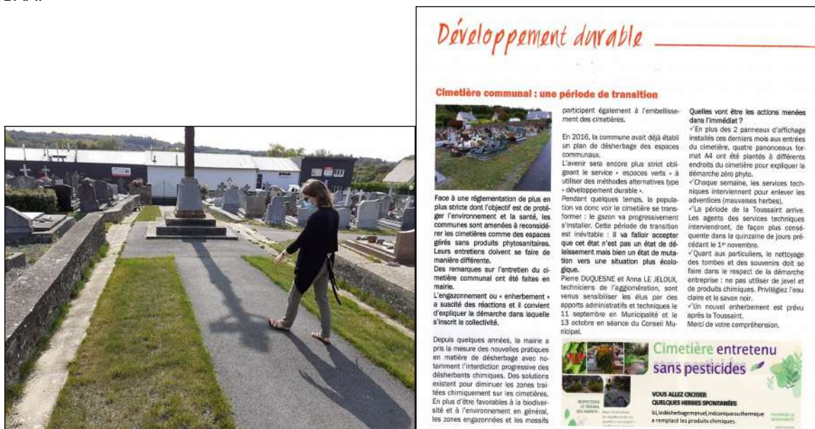
Allée principale du cimetière : enrobé et enherbement
