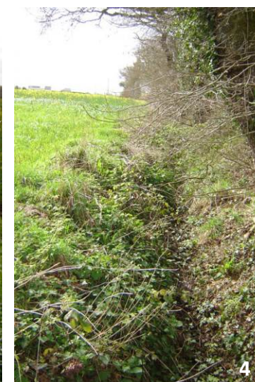
Photo 4 : fossé pré-existant au Nord de la parcelle où aboutirait une surverse de la dernière section du fossé aménagé. Sec au moment de la visite, pas de trace de ruissellement.
