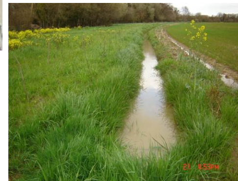
Photo 4 : section finale du fossé aveugle, trop plein générant une surverse continue
