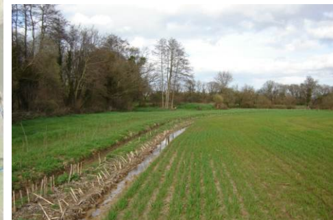
Photo 4 : section finale du fossé aveugle, trop plein générant une surverse continue
