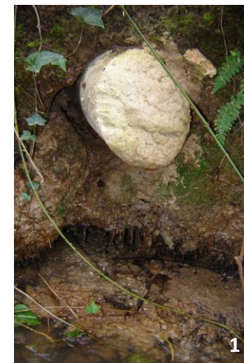
Photo 1 : obstruction de l'exutoire dans le ruisseau du collecteur principal (ciment à prise rapide). Un écoulement résiduel est constaté. Cette obstruction aurait pu intervenir un peu plus tard pour diminuer les risques de déchaussement de l'ouvrage et de déstabilisation de la berge.
