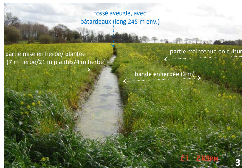
Photo 3 : vue du fossé depuis son exutoire : aucune surverse n'est constatée, pas de trace de ruissellement au sein de la végétation (8 m enherbés entre l'exutoire du fossé et le fossé pré-existant au nord de la parcelle).
