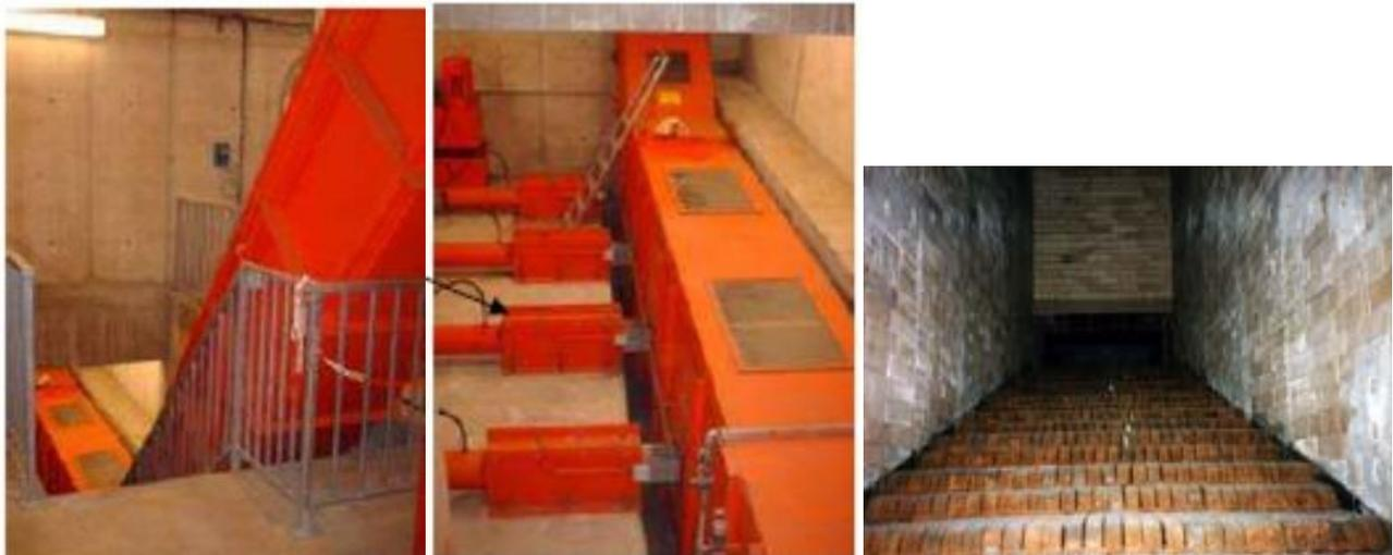
6 Illustration d'un dessilage par échelles racleuses, d'un convoyage par tapis et d'un foyer à grille
