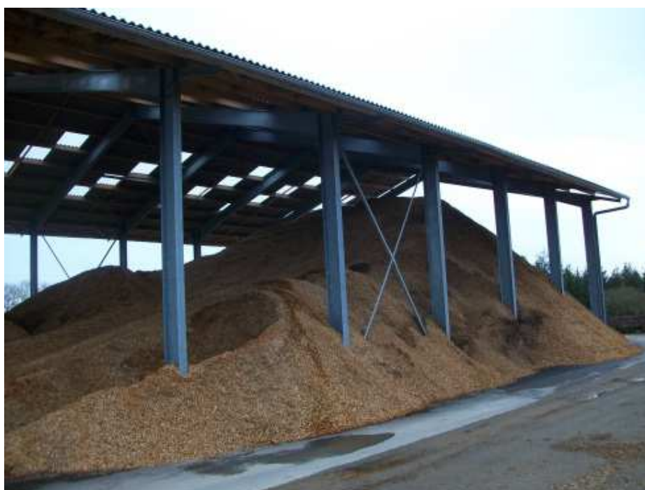
Figure 1 : Plateformes de Plounérin exploitée par la SCIC Bocagénèse
