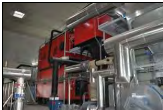
Chaudière biomasse/Malterie Soufflet de Nogent-sur-Seine (© Groupe Soufflet)
